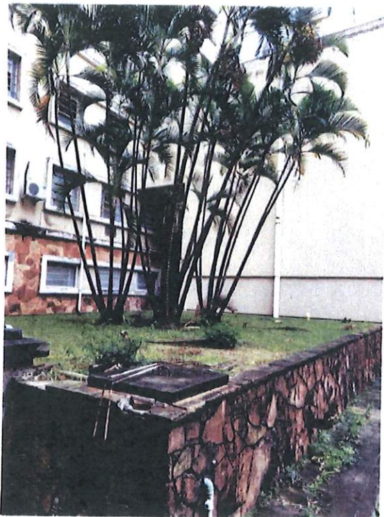
Foto 1 – Impermeabilização dos reservatórios, conforme memorial descritivo
