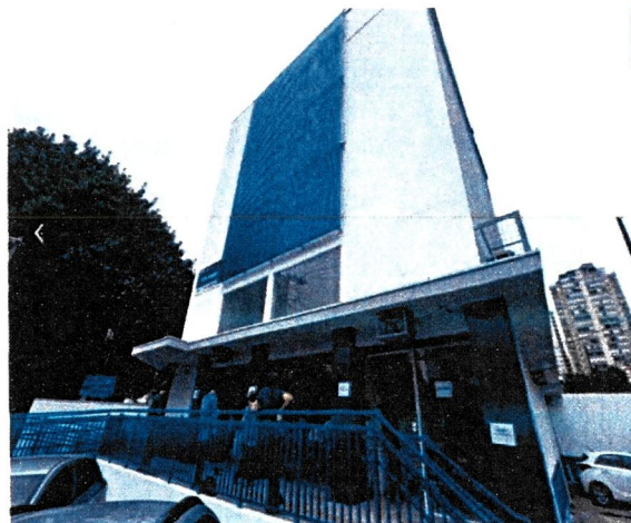
Foto 02– Local da instalação da cobertura.
