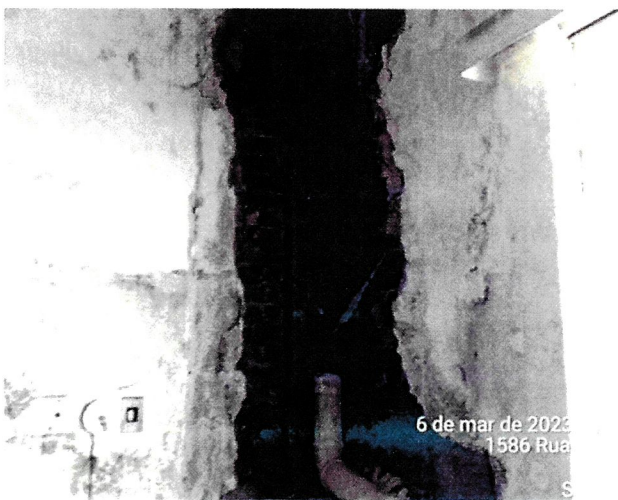
Foto 4 – Tubulação Pluvial 6º Pavimento
